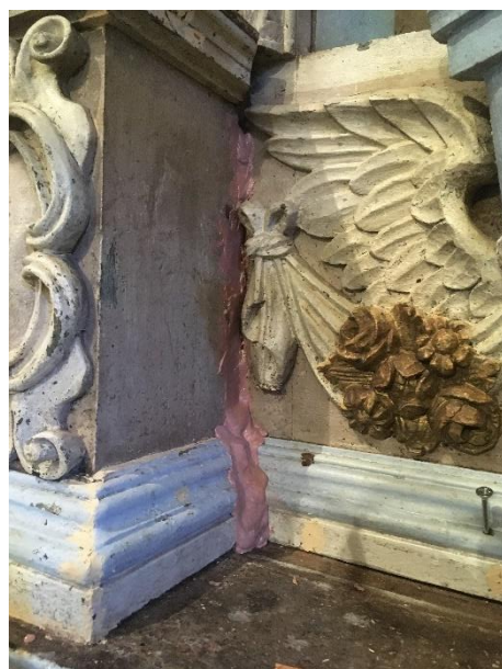
Comblement et masticage du joint avec le fond du panneau.
