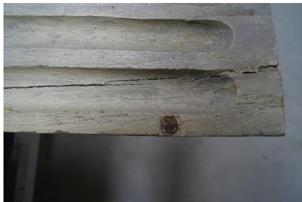
Recollage de la fente au niveau du pilastre à l'aide d'adhésif acrylique
