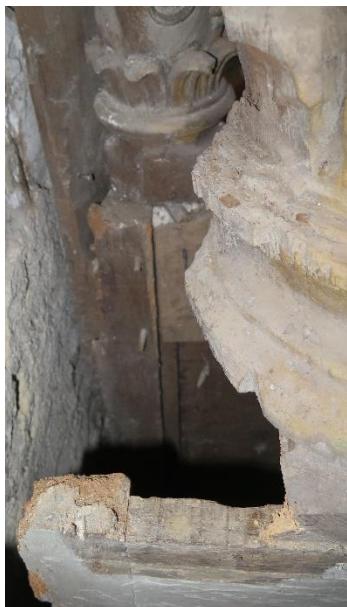
Vue de l'état de conservation du support de la colonne avant intervention
