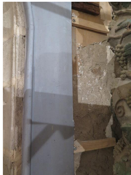
Mise en place de tasseaux / boulonnés à la maçonnerie pour fixation du pilastre
