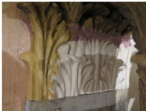
Complément du chapiteau de pilastre droit prise d'empreinte sur celui de gauche, tirage en plâtre, fixation par vis et ajustements à la résine.
