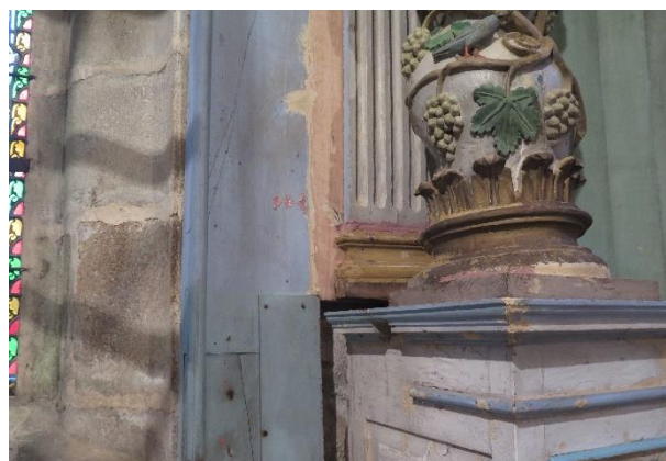
Changement de la planche de chêne servant de support au pilastre à l'arrière de la colonne de droite qui était complètement dégradée par les champignons. Elle a été fixée sur des tasseaux boulonnés à la maçonnerie. Puis le pilastre a été refixé par des vis.
