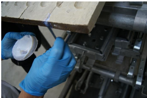
Recollage de la fente au niveau du pilastre à l'aide d'adhésif acrylique
