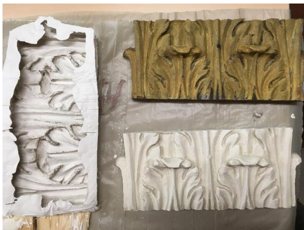
Complément du chapiteau de pilastre droit prise d'empreinte sur celui de gauche, tirage en plâtre, fixation par vis et ajustements à la résine.
