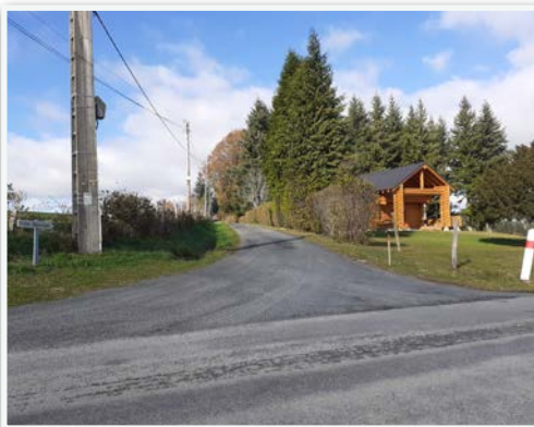
Réalisation d'un enduit bicouche sur la route du stade (VC 9) (7815 €) (Réal. 2021)
