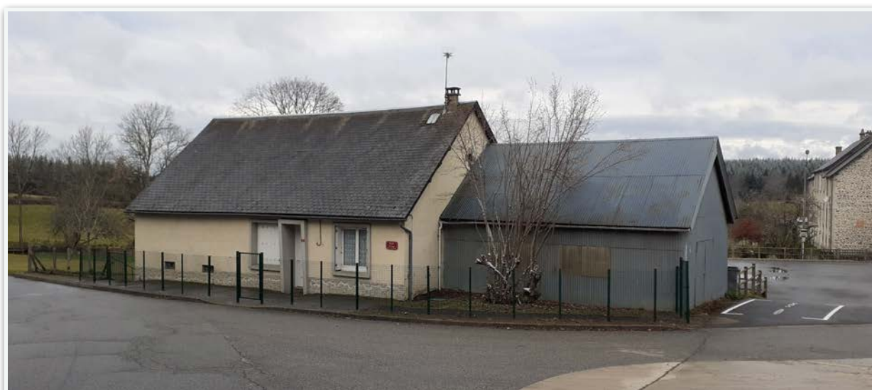
La maison Monjanel, située à l'entrée du Bourg, abritera la MAM. Des aménagements spécifiques ont été nécessaires pour répondre aux nombreuses normes de sécurité exigées par la PMI (Protection Maternelle infantile) et le SDIS
