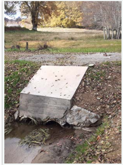
Un aqueduc a également été aménagé à proximité du village ASF pour faciliter l'évacuation de l'eau des pacages situés à proximité . Un étang s'était formé. (7118 €)(Réal. 2021)
