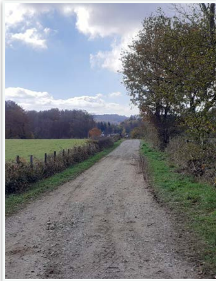
Renforcement de la Voie communale 49 aux abords du village ASF : Tout venant et sablage. (Réal. 2020)
