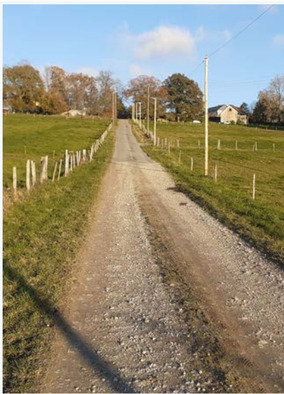
Renforcement du chemin (VC46) reliant Montasserre à Encognéras : goudronnage aux extrémités + GNT compacté (Grave non traitée = mélange de cailloux, de sable et graviers). (réal. 2020)
